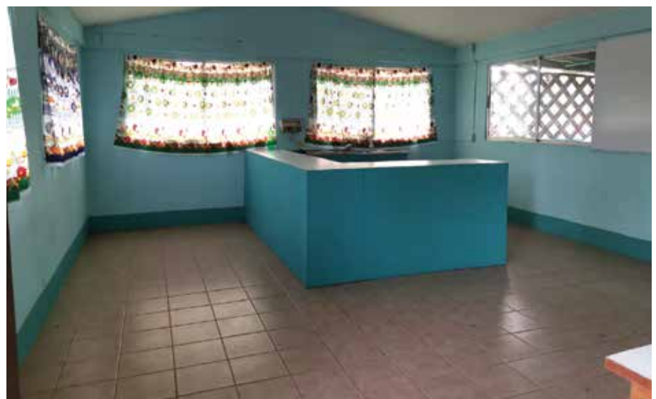
Instalaciones de la escuela Las Crucitas, en Cutris de San Carlos.
